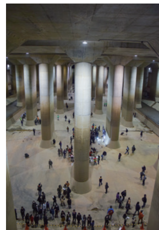
首都圏外郭放水路の見学会状況
