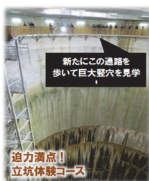
巨大立坑「第1立坑」
