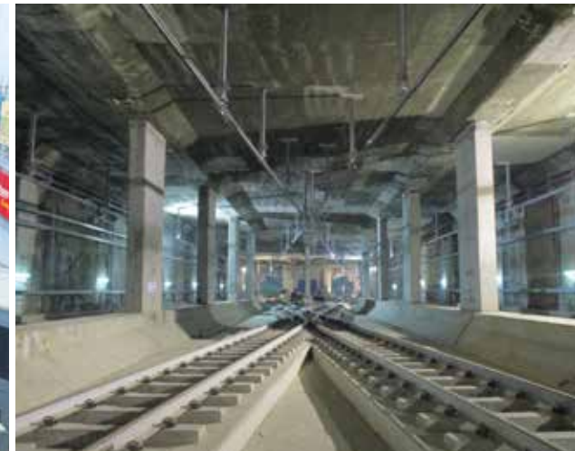
ブンデランハイ駅の南側に設置された地下軌道分岐／ Underground scissors crossing at south side of Bunderan HI Station
