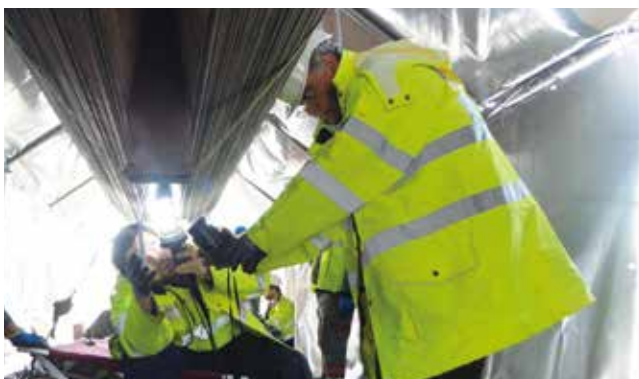
第1ボスポラス橋、主ケーブル開放調査／ First Bosphorus Bridge, Main cable inspection
