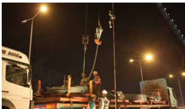
第1ボスポラス橋、夜間における鉛直ハンガーロープ取付工事／ First Bosphorus Bridge, Vertical hanger rope installation during night time
